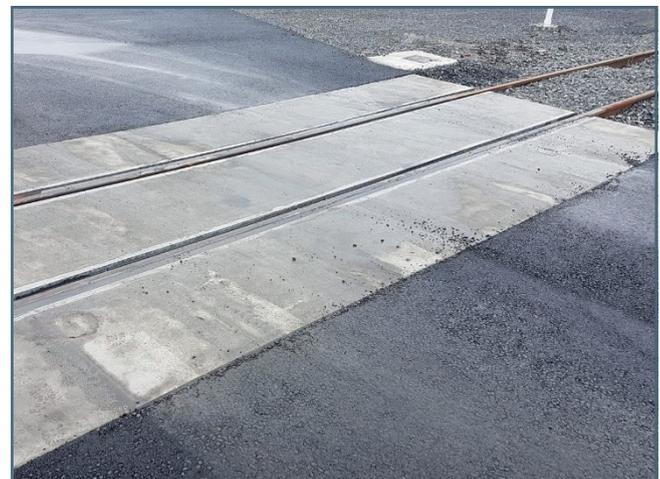
**A 'CONCRETE (EDILON) SLAB' LEVEL CROSSING**
