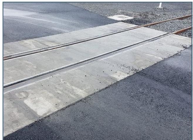
**A 'CONCRETE (EDILON) SLAB' LEVEL CROSSING**
